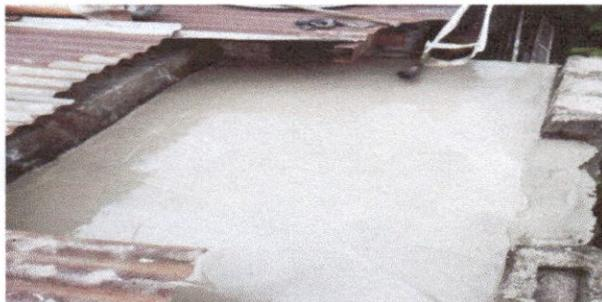
Foto1: impermeabilización de losa de los baños
